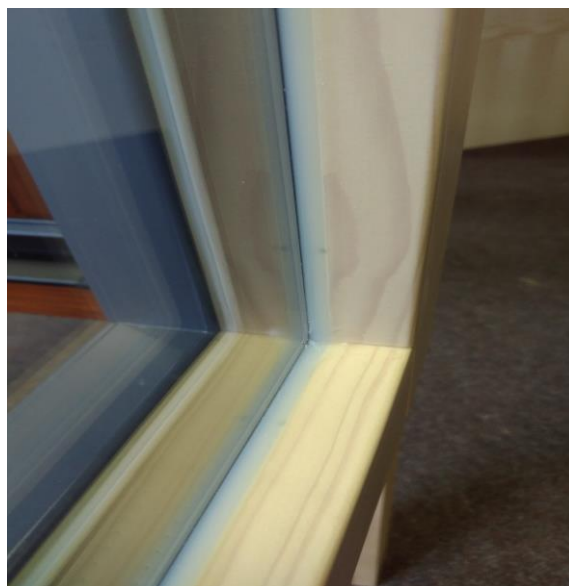
Abbildung 2: Intakte Silikonfuge
